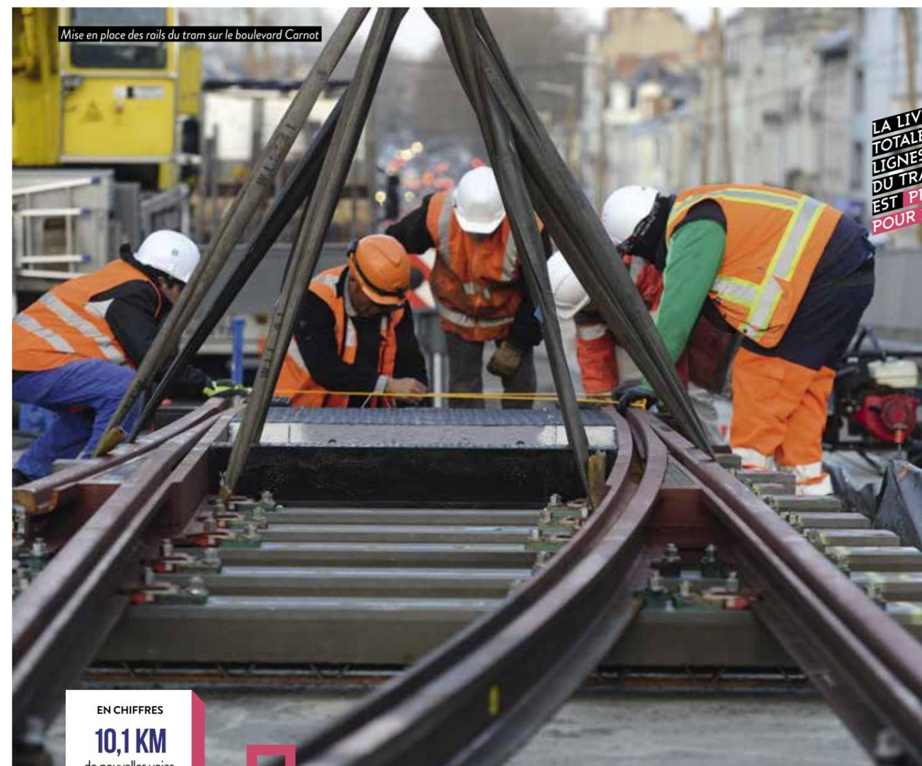
Mise en place des rails du tram sur le boulevard Carnot
