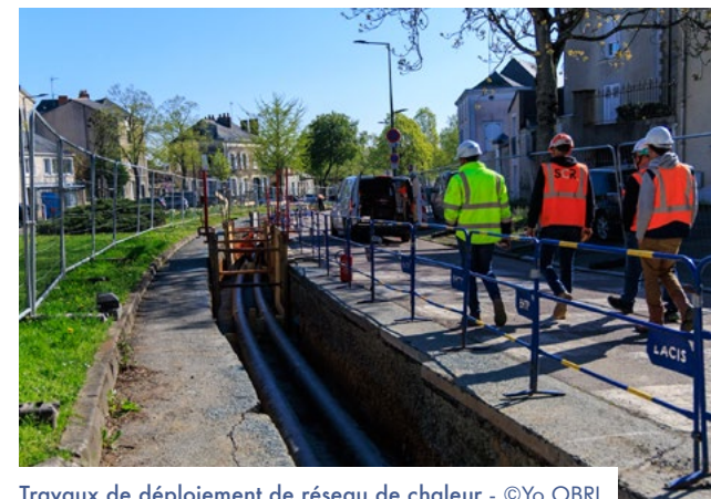
Travaux de déploiement de réseau de chaleur - ©Yo OBRI
