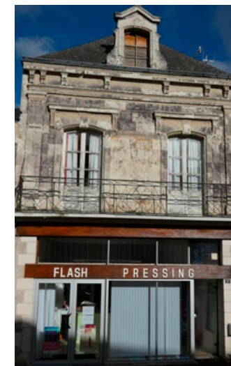
27 rue Basse – Baugé-en-Anjou
