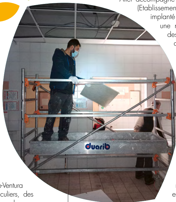
Dans l'architecture tertiaire, les faux plafonds posés sur des rails métalliques sont récurrents. Leur dépose est accessible ce qui permet le réemploi.
