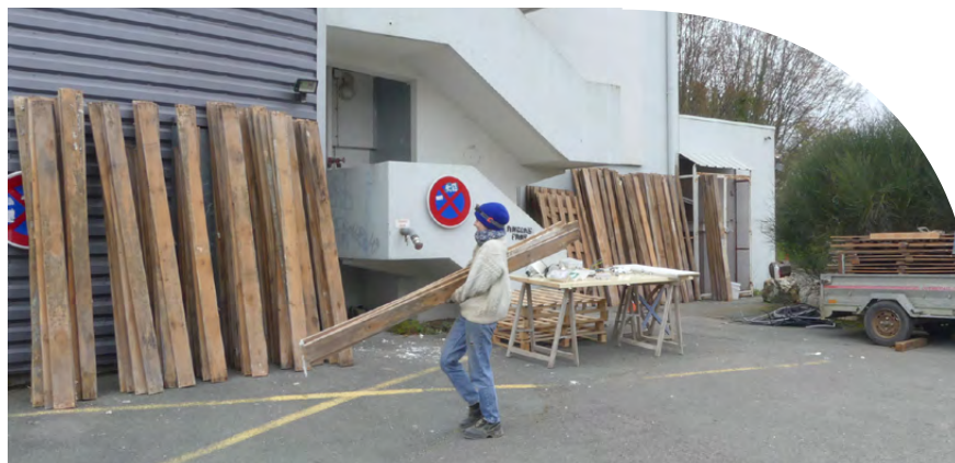
Le diagnostic PEMD (Produit, Équipement, Matériaux, Déchet) comprend l'étude des différents modes de valorisation et l'identification des potentiels de réemploi des « déchets » du bâtiment.
