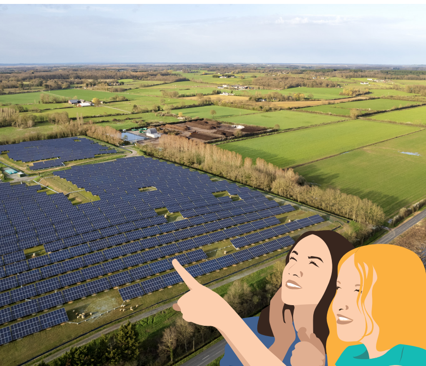
Centrale solaire au sol, «Smilé photov'», Tiercé
