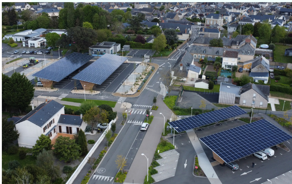
Ombrières de parking
