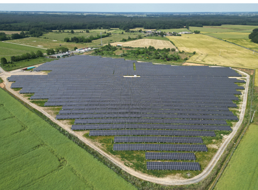
Centrale solaire au sol, «Champ de Liveau», Montreuil-Bellay
