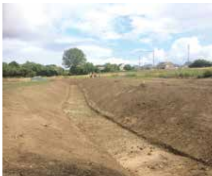
Aperçu d'un bassin de rétention des eaux pluviales
