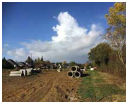
Travaux d'assainissement en cœur de quartier
