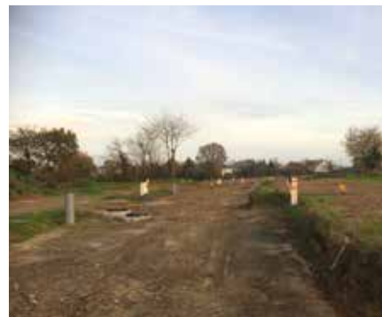
Viabilisation des terrains à bâtir
