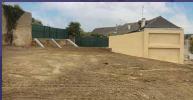
Fin des travaux d'étanchéité, de confortement définitif du mur mitoyen et du nivellement du terrain
