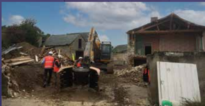
Travaux de démolition lourde des bâtiments.
