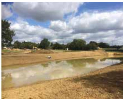
Bassin d'orage situé le long de la rue de Juigné
