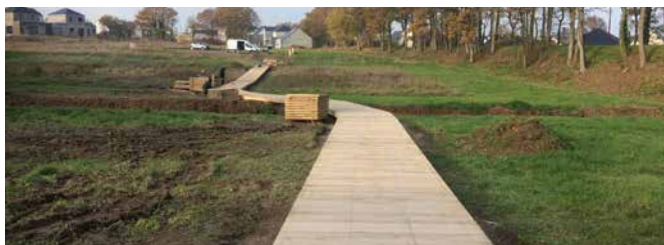
Passerelle en cours de construction en décembre 2022.
