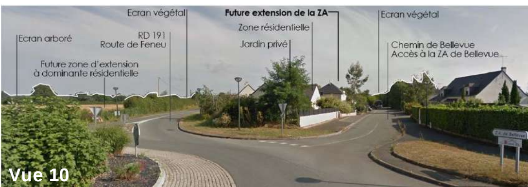
Giratoire desservant le Chemin de Bellevue, principal accès à la ZA de Bellevue.
