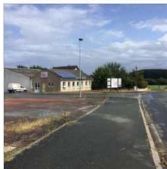
47 Plan CANTENAY périmètre + ZA actuelle -- Lot TCE Tous corps d'état Entrée de la ZA existante et de la rue de la Chênaie côté Est
