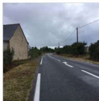
33 Plan CANTENAY périmètre + ZA actuelle -- Lot TCE Tous corps d'état D191 Route de Feneu vue depuis le Nord avec corps de ferme côté Est de la voie
