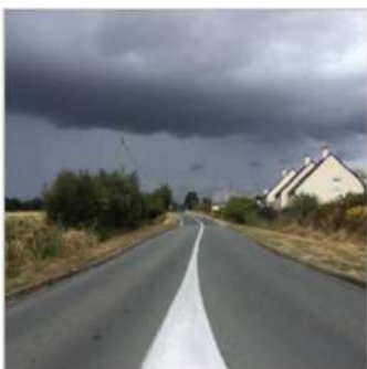
27 Plan CANTENAY périmètre + ZA actuelle -- Lot TCE Tous corps d'état D191 Route de Feneu vue depuis le giratoire
