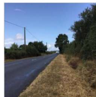
34 Plan CANTENAY périmètre + ZA actuelle -- Lot TCE Tous corps d'état D191 Route de Feneu > fossé côté Est longeant donc le site d'étude
