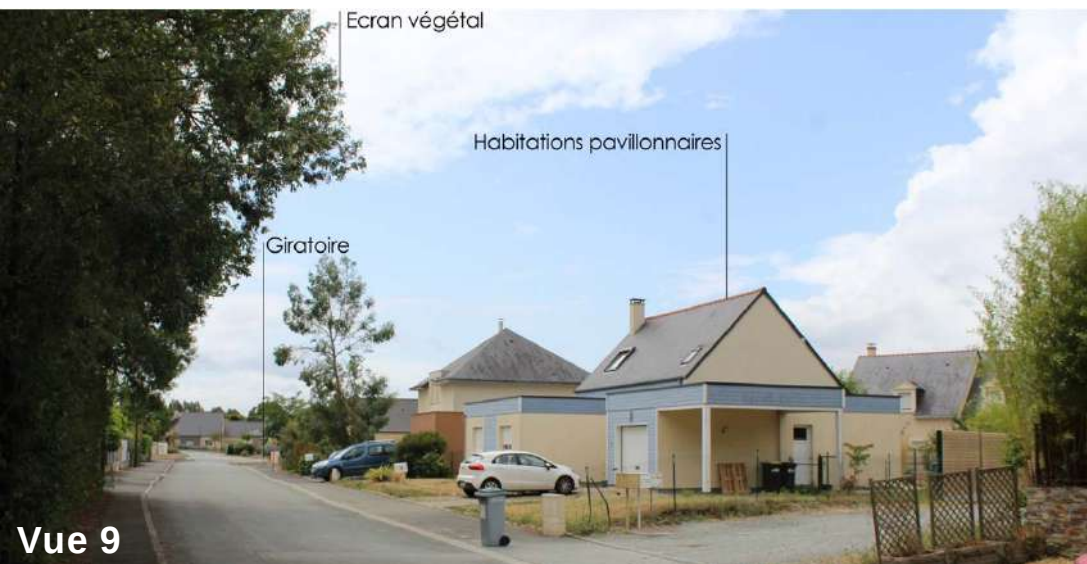
Des habitations pavillonnaires bordent le Chemin de Bellevue engendrant une mixité des flux entre la zone d'activités et la zone pavillonnaire.
