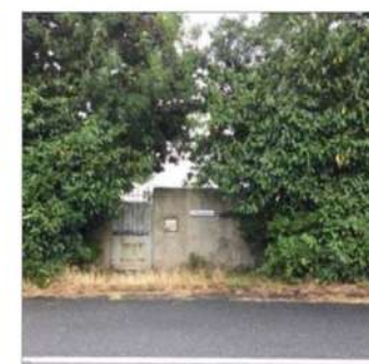
38 Plan CANTENAY périmètre + ZA actuelle -- Lot TCE Tous corps d'état Grande propriété longeant la haie Nord délimitant Sud. entrée piétonne côté Ouest du site d'étude
