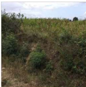
8 Plan CANTENAY périmètre + ZA actuelle -- Lot TCE Tous corps d'état Vue sur le fossé et le talus longeant le côté Ouest du Chemin de Bellevue
