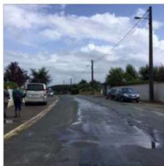
41 Plan CANTENAY périmètre + ZA actuelle -- Lot TCE Tous corps d'état Rue de la Croix de Sarthe vue l'Est depuis le giratoire
