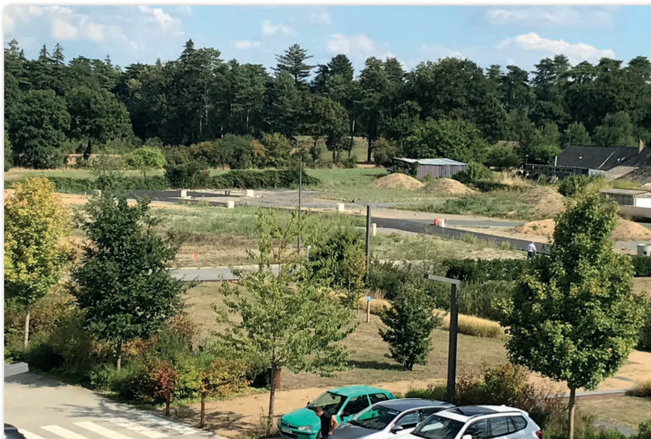
Travaux de viabilisation du secteur Anthaise
