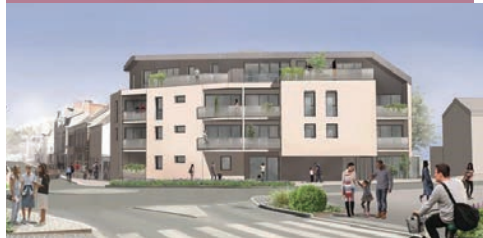
Ancien HOTEL DE LA GARE Maine et Loire habitat
